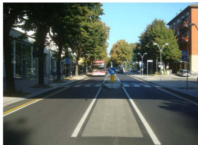
Figura 1: esempi di fasce centrali polifunzionali
