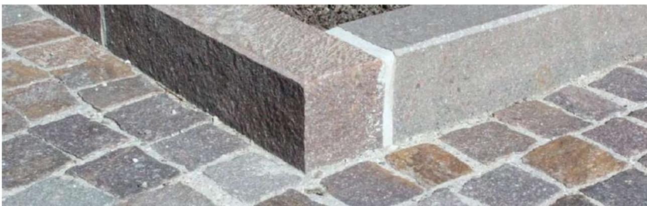
**Trachite euganea:** utilizzata per il disegno della parte pedonale di Piazza Fermi. Verrà trattata con diverse finiture, esplicitate negli elaborati grafici, per dare movimento e ulteriore pregio allo spazio centrale del progetto. Inoltre, è stata selezionata per ricalcare l'asse di simmetria storico di Villa Fornoni. Il disegno della piazza è impreziosito da innesti di pietra bianca che richiama la pavimentazione antistante la villa.
